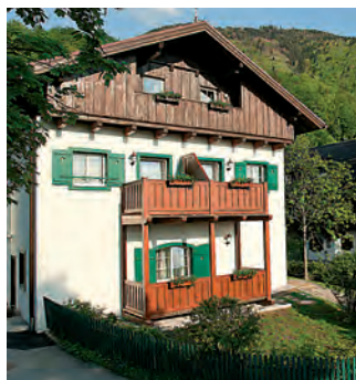
Die Sanierung der Gersbergalm konnte erfolgreich abgeschlossen werden (Bilder: La-Linea)
